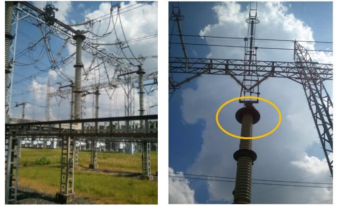
Hình 6 Kiểm chứng phát hiện phóng điện cục bộ bộ ngắt mạch 275 kV
