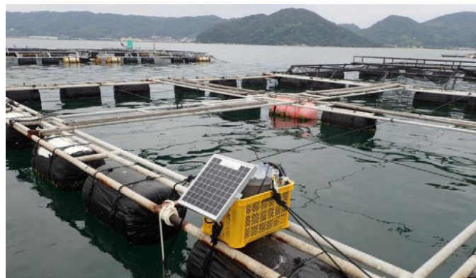
Hình 9 Hiện trường lắp đặt hệ thống truyền tin giám sát liên tục số liệu 2 cảm biến HAI
