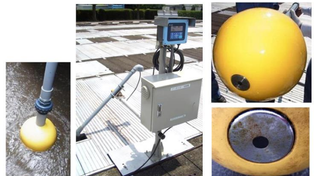
Hình 13 Hiện trường lắp đặt (bể phản ứng) nhà máy xử lý nước thải C, cài đặt giá đỡ kiểu phao.
