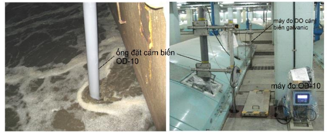
Hình 11 Hiện trường lắp đặt (bể phản ứng)
